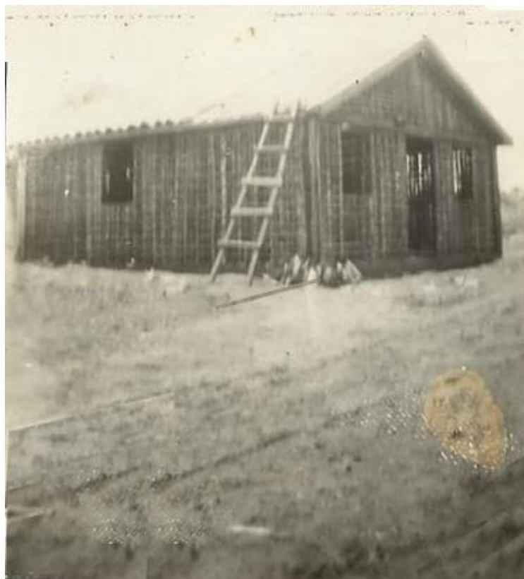
Casa em construção de Orlando Miguel Vicente, irmão de José Vicente
