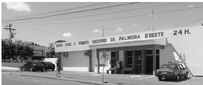
Reforma do Pronto Socorro e do S.A.M.U nas dependências da Santa Casa de Misericórdia.
