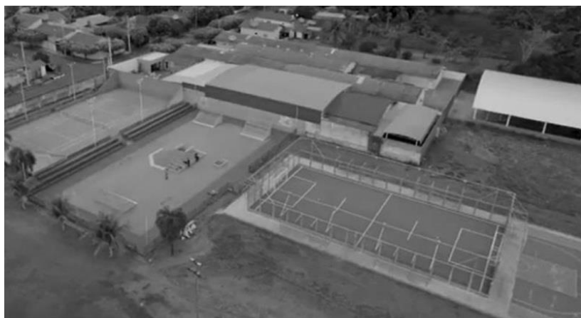
Construção da “Areninha”.
