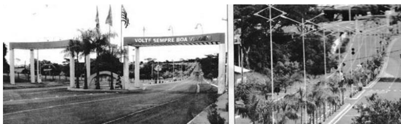
Portal e duplicação da via de acesso "Avenida Joaquim Vaccari".
