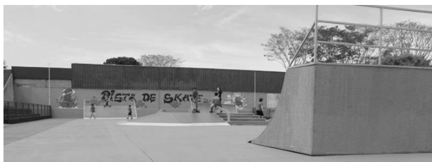
Construção da Pista de Skate.
