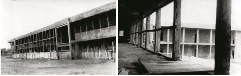
Construção do prédio
