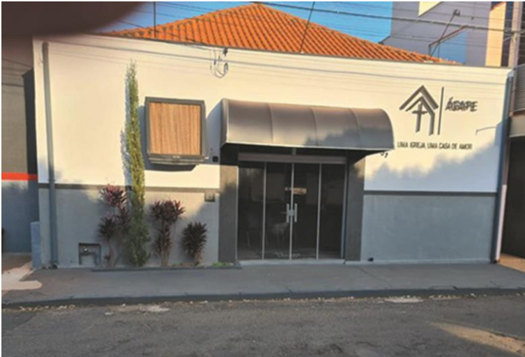
Fachada da Igreja Ágape – Amar e Cuida
