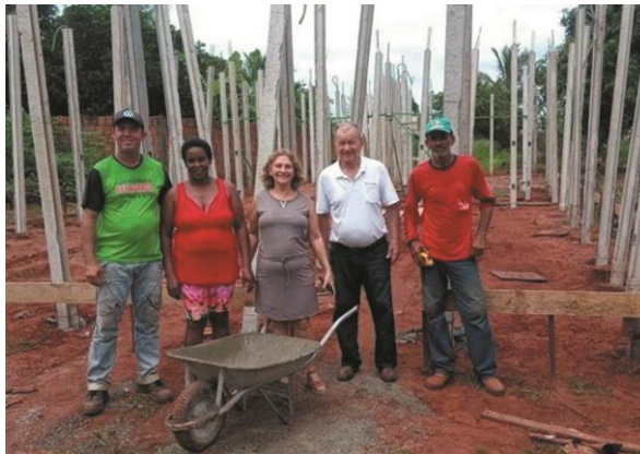
Construção do Lar de Amparo Esperança e Renovação em Dalas
