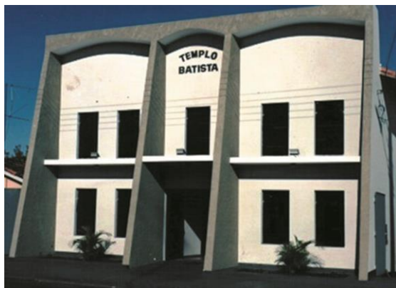
Fachada do Templo Batista logo após sua construção
