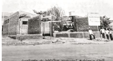
Construção do prédio da Biblioteca Pública Municipal
